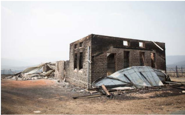
Kiandra Courthouse ruin.
